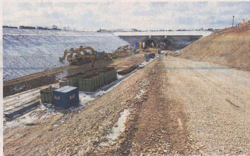
Ein Blick auf die beiden Tunnelröhren am Nordportal. FOTOS: PETER WÖLK
