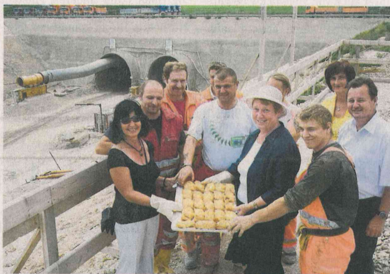
Zuvor hatten die beiden Tunnel-Patinnen den Mineuren in alter Tradition frisch gebackenen Speckkuchen übergeben.
